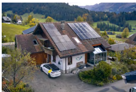
Bei vollem Sonnenschein verfügt das Dachkraftwerk über eine Leistung von 25,62 Kilowatt-Peak.
